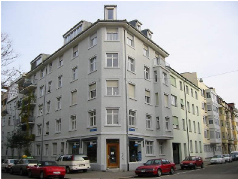
Blockrandbau. Schlettstadterstr. 9, 4055 Basel
